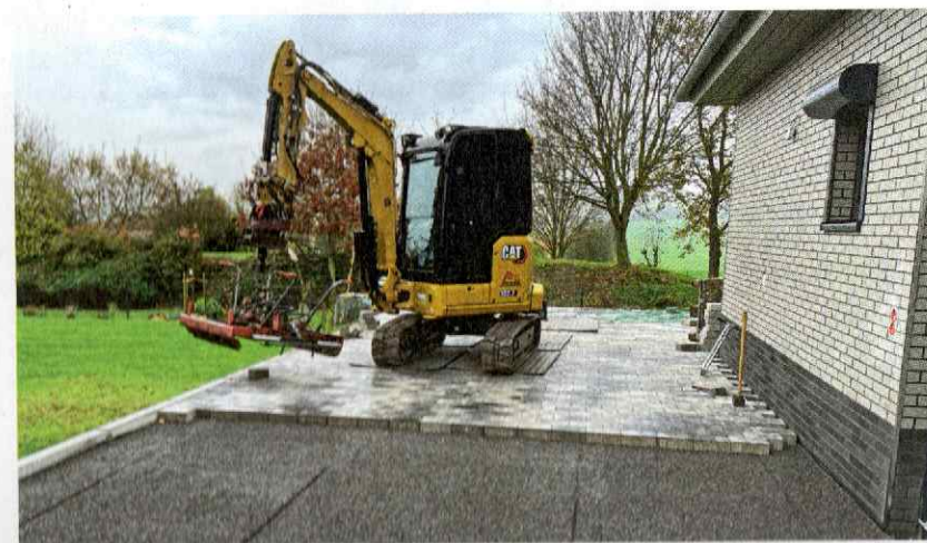
Zielgenaues Arbeiten mit der Pflasterverlegemaschine durch den Rototop.
