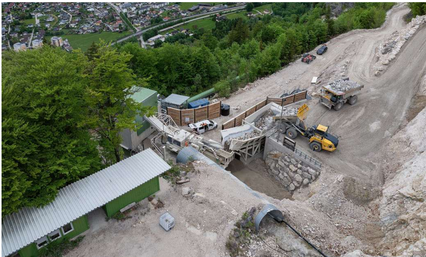
Aus der Luft ist die Nähe der Anlage zum Dorf gut erkennbar. Die Lärmschutzwände und die Staubbindeanlage schützen die Anwohner.
