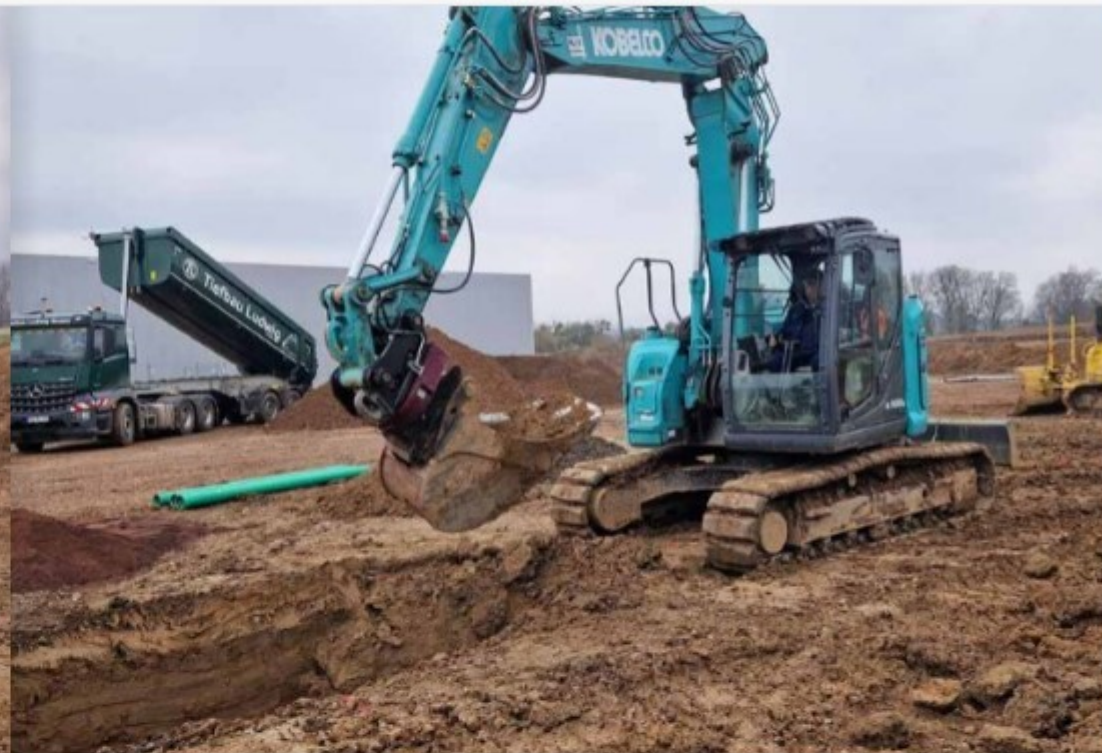
➤ Dank RotoTop verfügt der Bagger über die maximale Flexibilität am Rogenarm, was besonders bei der Verlegung von Versorgungsleitungen wichtig ist.
