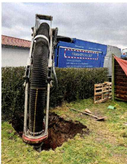
Reparaturen an im Garten verlegten Leitungen? Der Aushub kann mit dem Saugbagger ohne weitere Beschädigungen der Gartenanlage erledigt werden.
